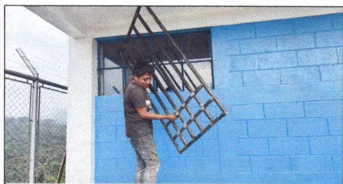
Fotografía 5. Fabricación e instalación de balcones de hierro en ventana
