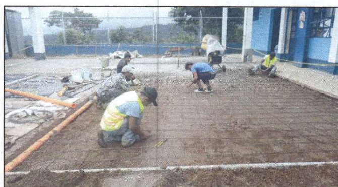
Fotografía 4. Reparación de plancha de concreto de patio.
