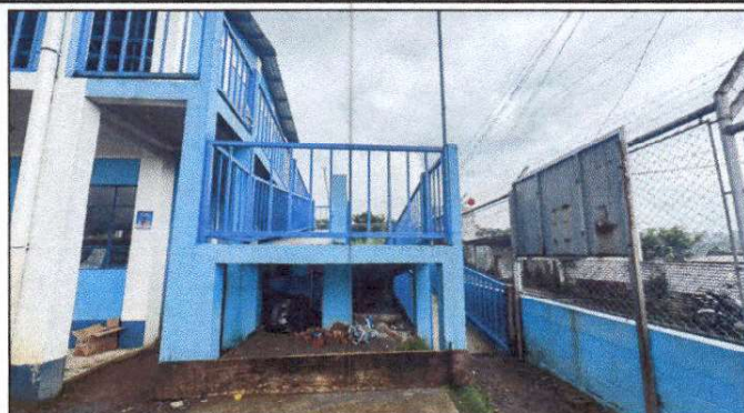
Fotografía 2. Mantenimiento a barandas de metal.
