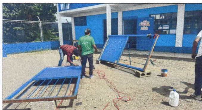
Fotografía 3. Mantenimiento a portones de metal.
