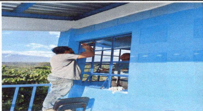
Fotografía 1. Sustitución de ventanas de madera por metal mas vidrio.
